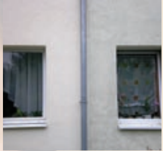
Vergleich der Verschmutzungsneigung nach 2 Jahren: NanoporPutz links, herkömmlicher Putz rechts
